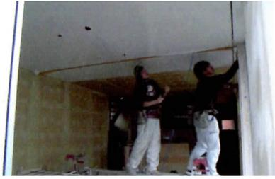
クロス工事 下地処理をした後、クロスを貼っていきます。
