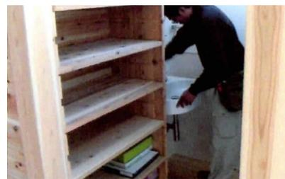
洗面台など衛生機器の取付と配管の接続を行います。
