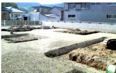
基礎の底となる部分に砕石を敷き、転圧をかけて締固めます。
