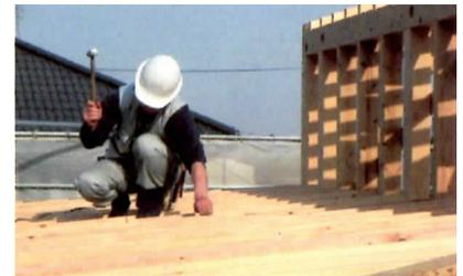
棟が上がった後は、屋根組へ。屋根の下地を仕上げしていきます。
