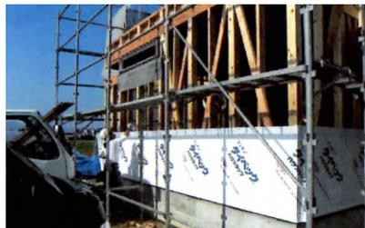
その後、外周部分に透湿防水シートを張っていきます。外壁から侵入してきた雨水を防ぐためのものです。
