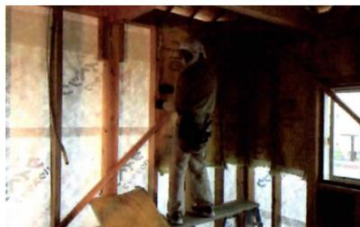
壁は充填断熱工法。繊維状の断熱材を使用。施工性がよく、コストパフォーマンスに優れています。
