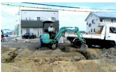
根伐りと呼ばれる掘方を行います。重機により地盤を掘削する作業です。
