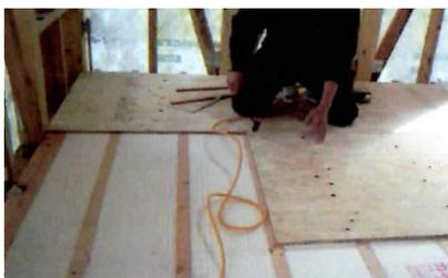
床下地工事 下地に構造用合板を張ることで、床の剛性を高めます。(変形しにくい床を造ります。)
