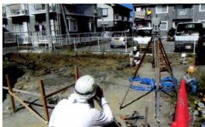
縄張りを元に、位置、水平、基礎の高さなど建物の基準となる線を確定していきます。
