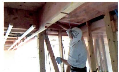
天井も壁と同じ繊維タイプの充填断熱。隙間がないよう、脱落しないよう丁寧に施工します。
