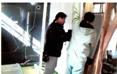
ユニットバス設置工事 壁を仕上げる前に設置します。
