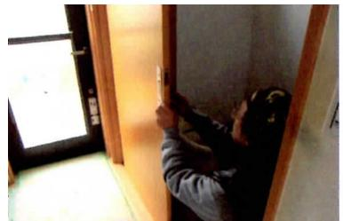
調整した建具を吊り込みます。
