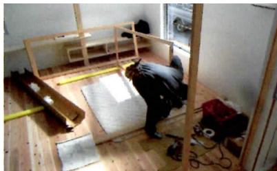
切り込み 製作建具は、現場でサイズの調整をして、削ったり取手をつけたりします。
