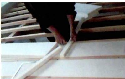
床断熱工事は、水に強く耐湿性のあるボード状断熱材を使います。
