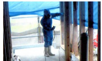
内部造作工事に入る前に、地面から1m以下の部分に、防虫防蟻処理を施します。
