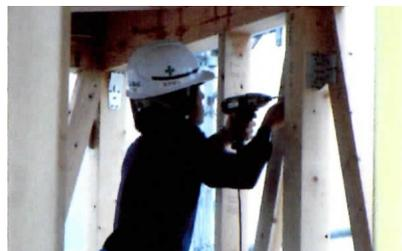
構造耐力上必要な部分に、所定の金物を取り付けます。
